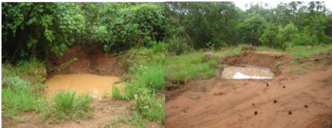
Figura 10. Caixas de retenção de água.
